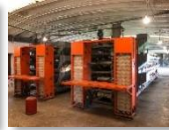
1 Bâtiment d'élevage de poule pondeuse
